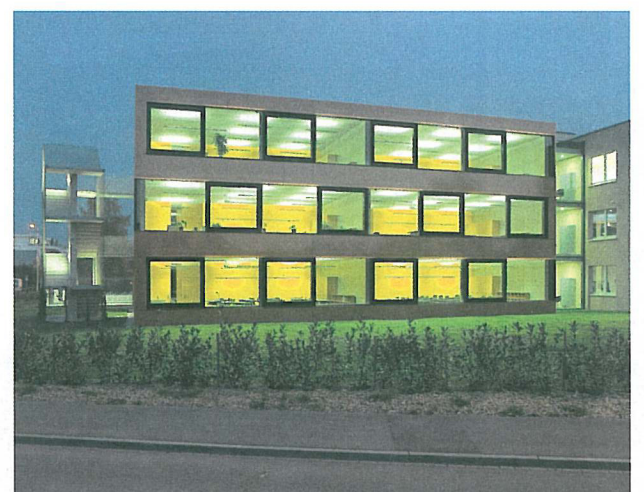
1 Die Struktur des Neubaus ist simpel: ein Gang mit Zimmern an beiden Seiten. Die Kupplung zwischen Alt- und Neubau ist gleichzeitig ein Aufenthaltsbereich.
