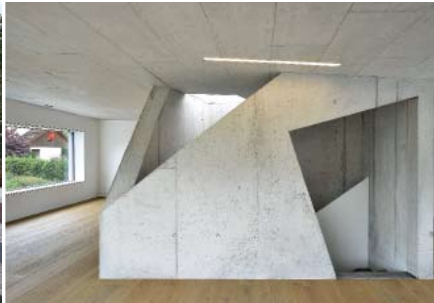
Die hangseitige Wohnung wird von einem innen liegenden Treppenkern erschlossen; polygonale Ausschnitte in Wand und Decke sorgen für die Belichtung.
