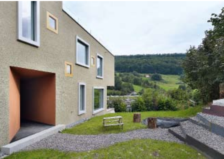
Horizontal gezogener Putz in Graugrün wechselt sich mit rotbraunem Feinputz an den Schnittflächen des Gebäudes ab. Auch die Farbe der Fensterrahmen variiert.
