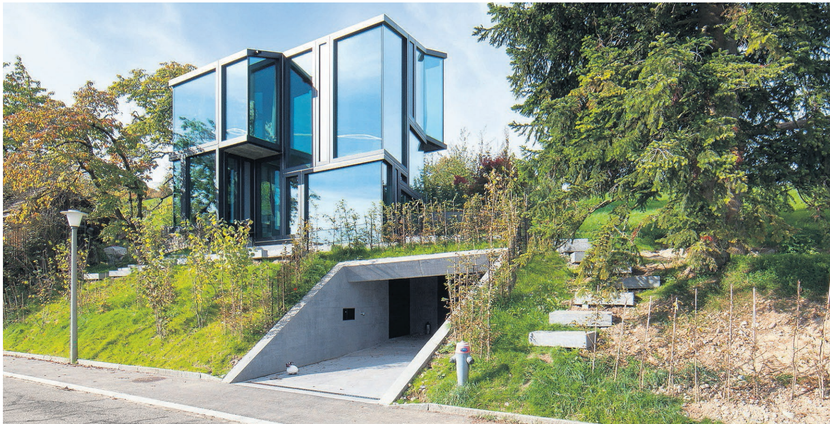
Skulpturaler Charakter: Das mehrfach ausgezeichnete «Weinstockhaus» in Dielsdorf ist ein Werk der L3P Architekten.
