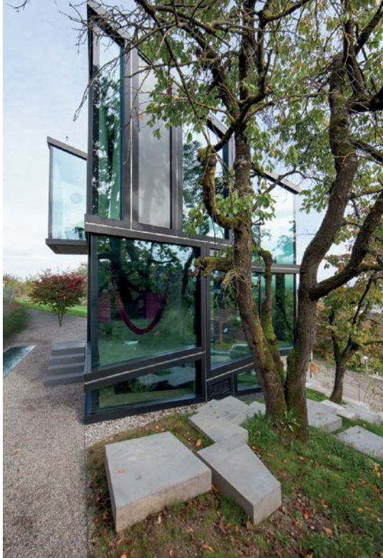
Les dalles marquant le cheminement autour de la maison ont été fabriquées avec les restes de béton du chantier.
