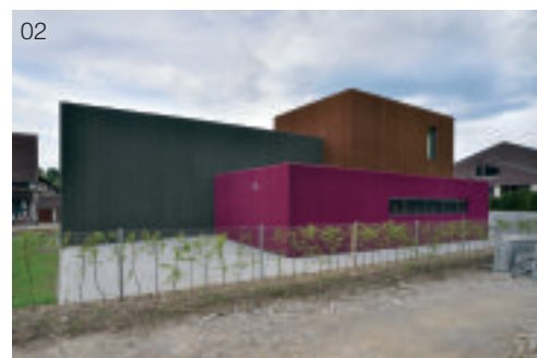
01 建筑正立面，入口的上方草黄色体块就是多用途空间
