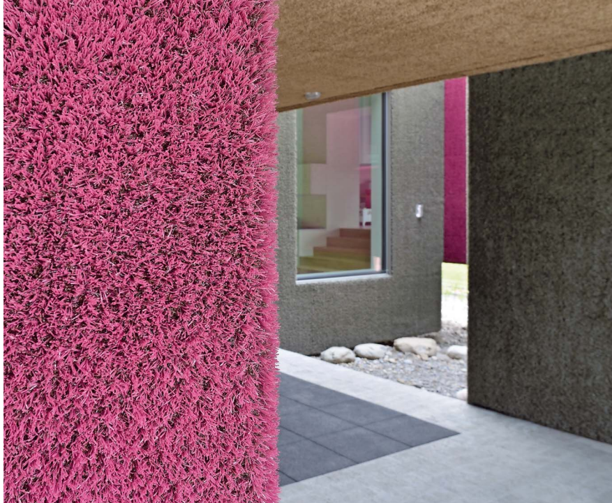
Zwei Florarten sorgen dafür, dass der Polyethylen-Kunstrasen einen plüschigen Charakter bekommt. Das Material wird in zwölf Colorits von Tisca Tiara produziert.
