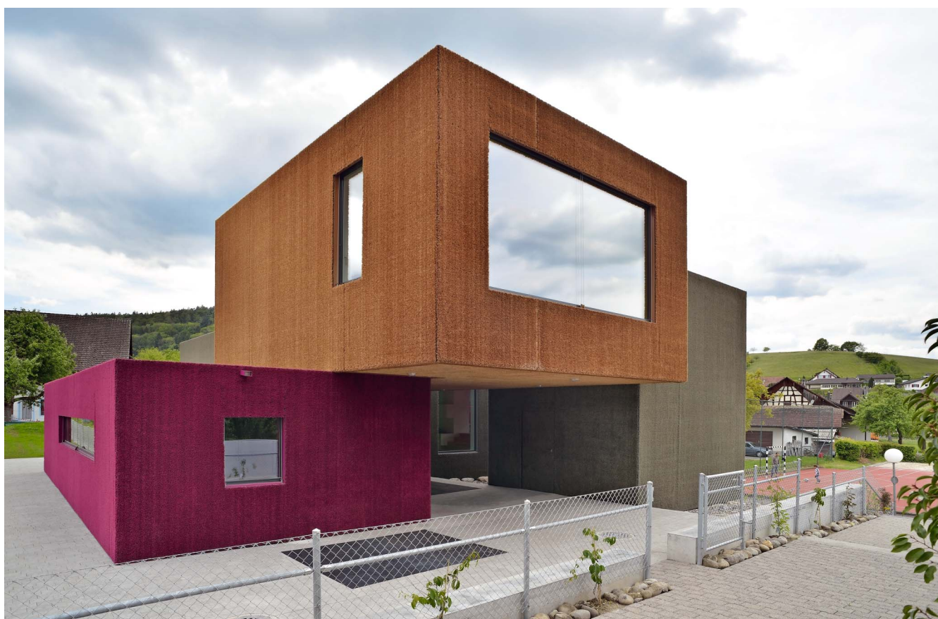
Von der Horizontalen in die Vertikale: Die Fassaden des Kindergartens Weiach sind mit farbigem Kunstrasen bekleidet. Die vier Meter breiten Bahnen wurden vor Ort zugeschnitten und mit der hinterlüfteten Alu-Unterkonstruktion vernietet.
