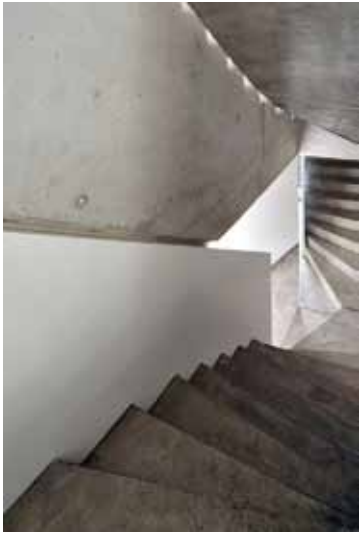
Die Treppe der talseitigen Wohnung führt hier vom Erdgeschoss ins Untergeschoss
