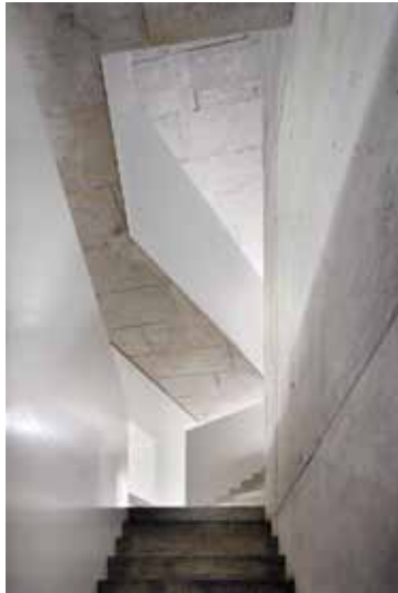
Die mal freie, mal geschlossene Treppe erschließt die dreigeschossige talseitige Wohnung
